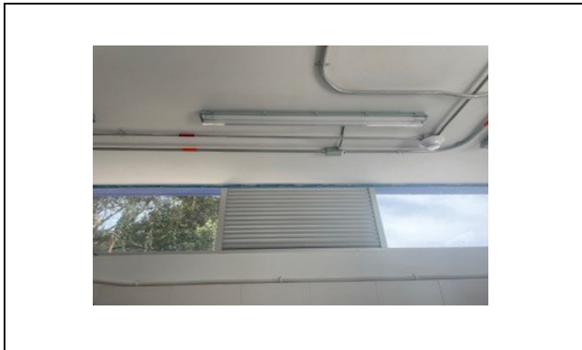
Foto. 13 Ventanales con cinta de seguridad
