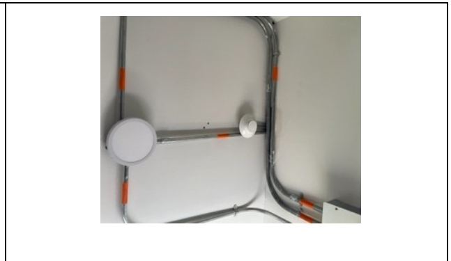
Foto. 2 Orificios sin resanar
