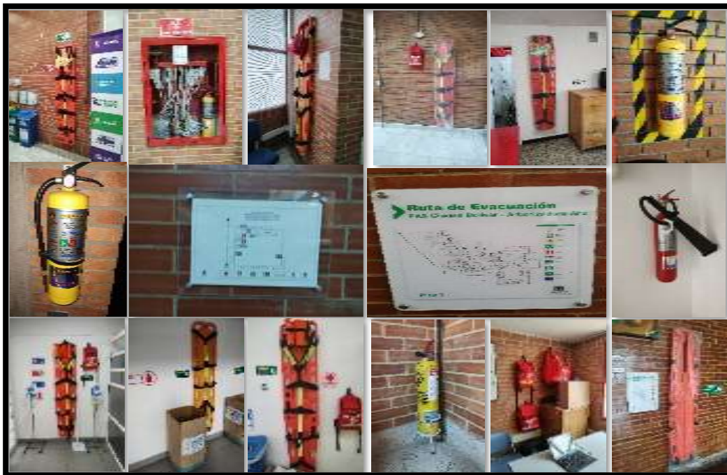
Imagen No 1 – Evidencias fotográficas, cumplimientos en Ambientes adecuados y seguros- Plan de Emergencias – SLIS auditadas.
