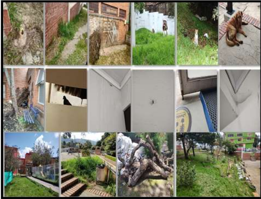
Imagen No 4 – Evidencias fotográficas, incumplimientos en manejo Integral contra la Proliferación de vectores en las SLIS.
