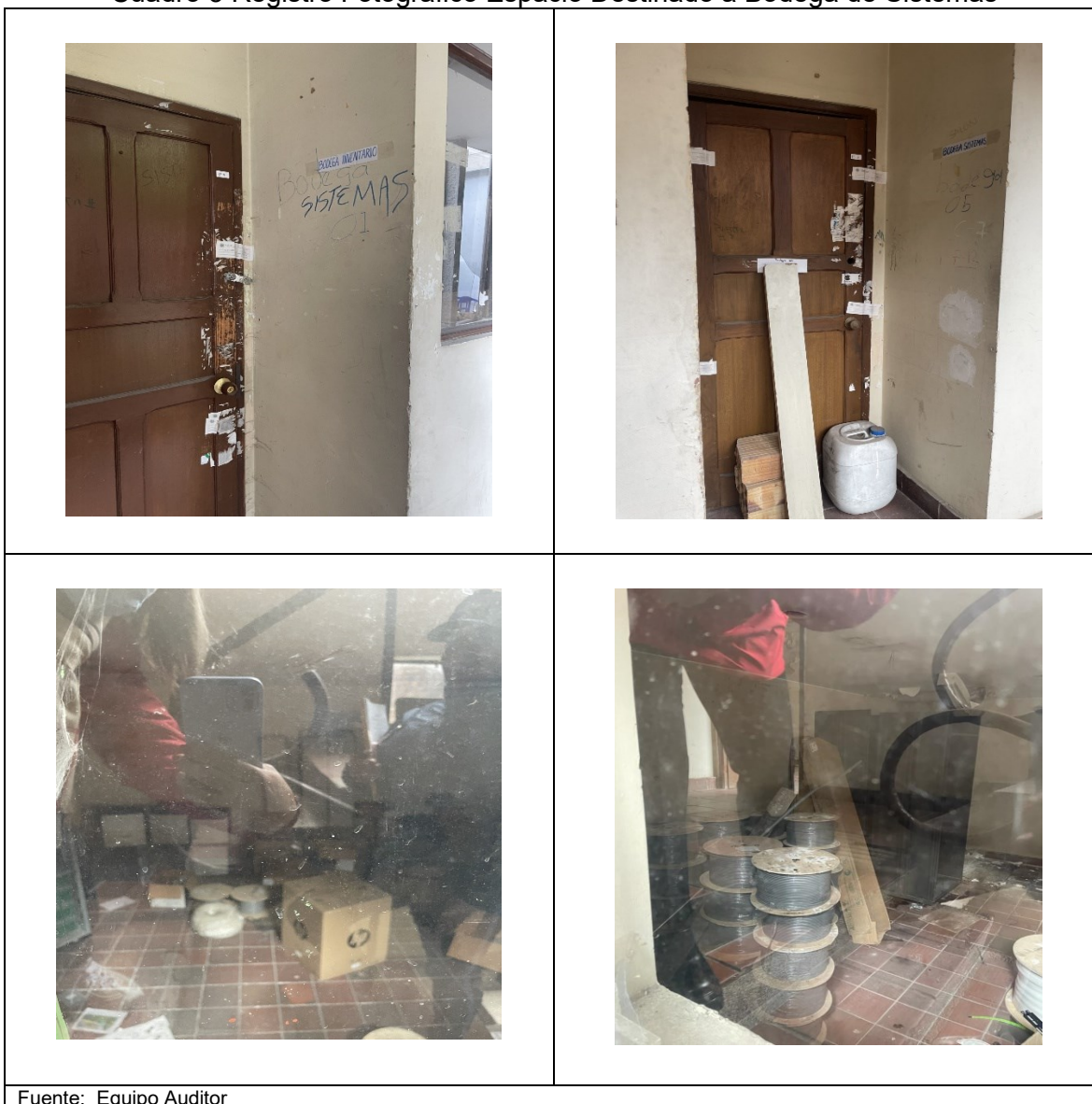
Cuadro 3 Registro Fotográfico Espacio Destinado a Bodega de Sistemas
