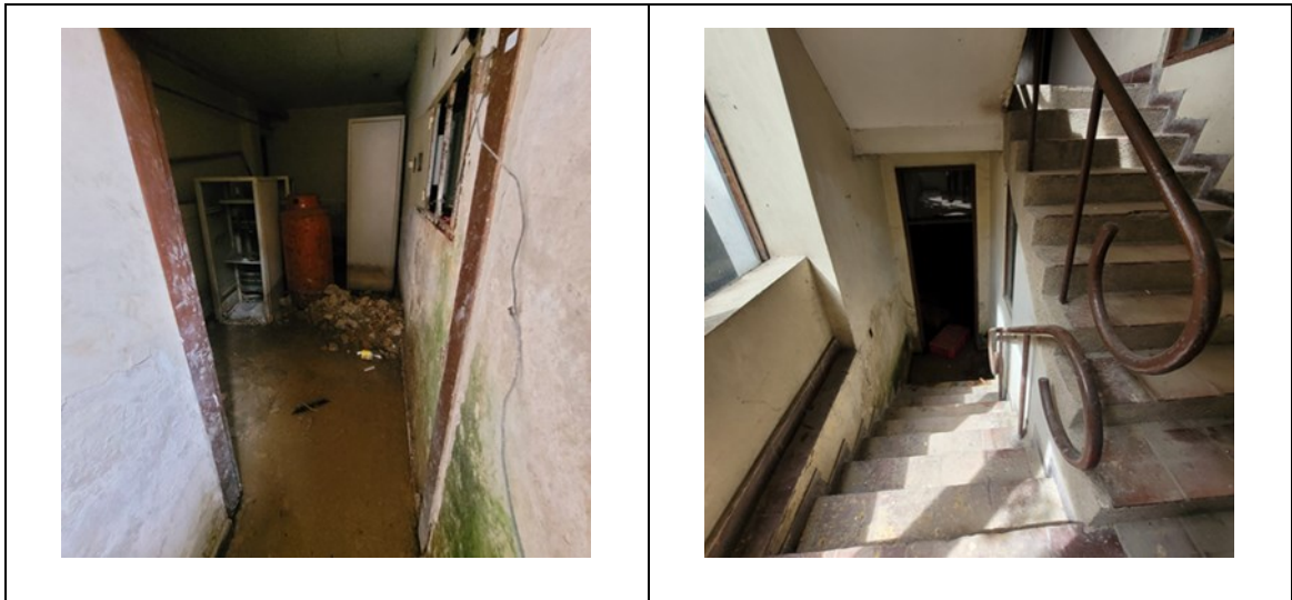
Cuadro 12 Registro fotográfico Motobomba
